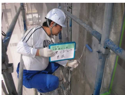
浸透性吸水防止剤（CBウォーター）をローラーで塗装
