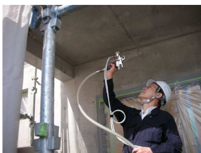
光触媒ルミチタン外装塗料をスプレーガンにて塗布（ガンノズル／0.8mm） ※横方向＋縦方向の一層コート
