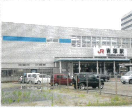
JR吉塚駅 (カラー鋼板外壁)
