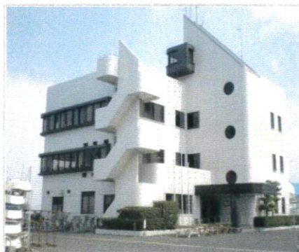
ヨットハーバー改修／佐賀県 (タイル外壁)
