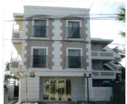
マンション改修／兵庫県 (塗装+タイル外壁)
