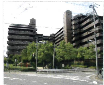
マンション大規模改修／大阪府 (タイル外壁)
