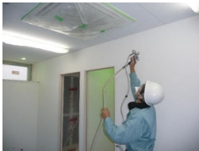
【光触媒「ルミチタンNAG」を横方向塗布、横方向の塗布表面が乾燥した後、縦方向の塗布】
