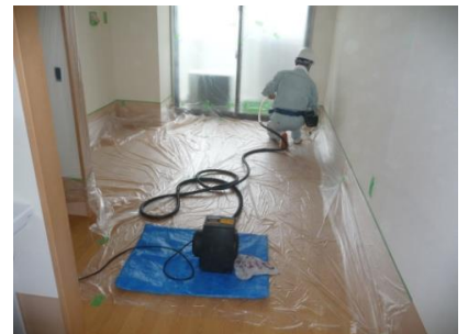
【「ルミチタンNAG」をスプレーガンで塗布（横塗り+縦塗り）】
