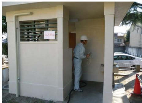
<光触媒室内塗料「ルミチタンNAG」の塗布>
