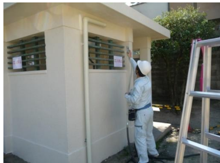
<光触媒屋外用塗料の塗布>
