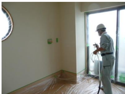
【「ルミチタンNAG」をスプレーガンで塗布（横塗り+縦塗り）】
