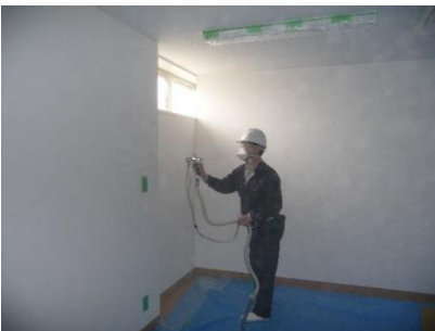
【光触媒「ルミチタンNAG」を横方向塗布、横方向の塗布表面が乾燥した後、縦方向の塗布】
